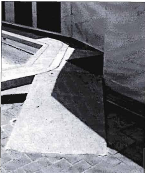
Paso desde Patio de la piscina a patio de las piramidales.
