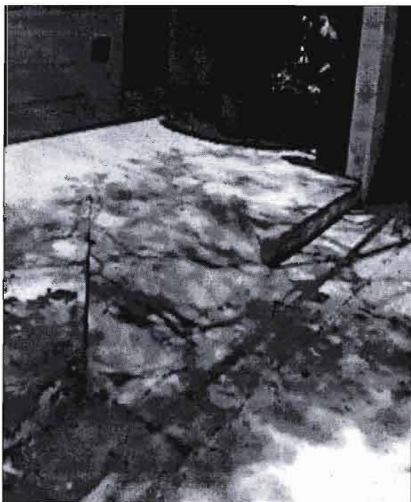
Paso de entrada Albán Borja a Patio de Comunicación.
